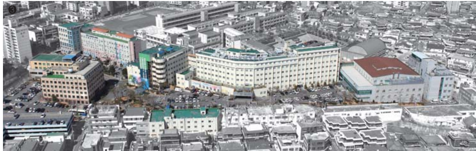
① 신임생 환영회 도중 저수지를 바라보며 사색에 잠긴 서석조 박사의 뒷모습 ② 개원 전 신축공사 모습. ③ 2012년 전경사진-항공사진.
